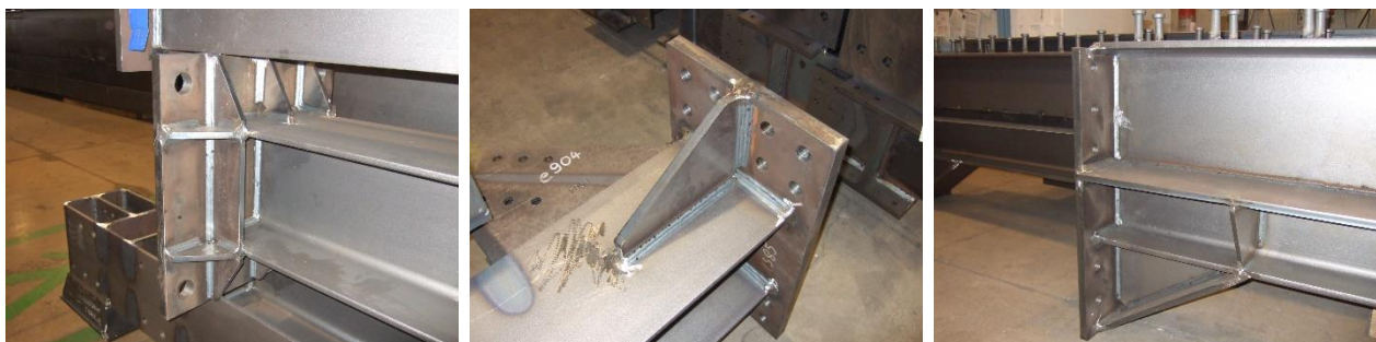
Fig.11 – Componenti strutturali saldati in officina
